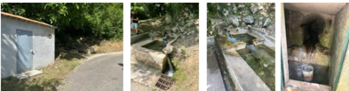
La source du Lavoir se situe à environ 75 mètres au-dessus du hameau de Bramafan, au nord, en bordure du chemin rural des Cabanes. Elle se caractérise par une étroite galerie, protégée par un ouvrage bétonné, fermé par une porte métallique tenue verrouillée. La galerie aboutit à un petit bassin de décantation qui alimente le lavoir situé à proximité immédiate à partir duquel le réseau d'alimentation du hameau de Bramafan prend son départ.
